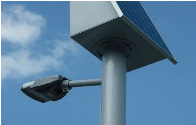
- con energia solar, France
